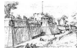
Fortezza da Basso I Bastioni
